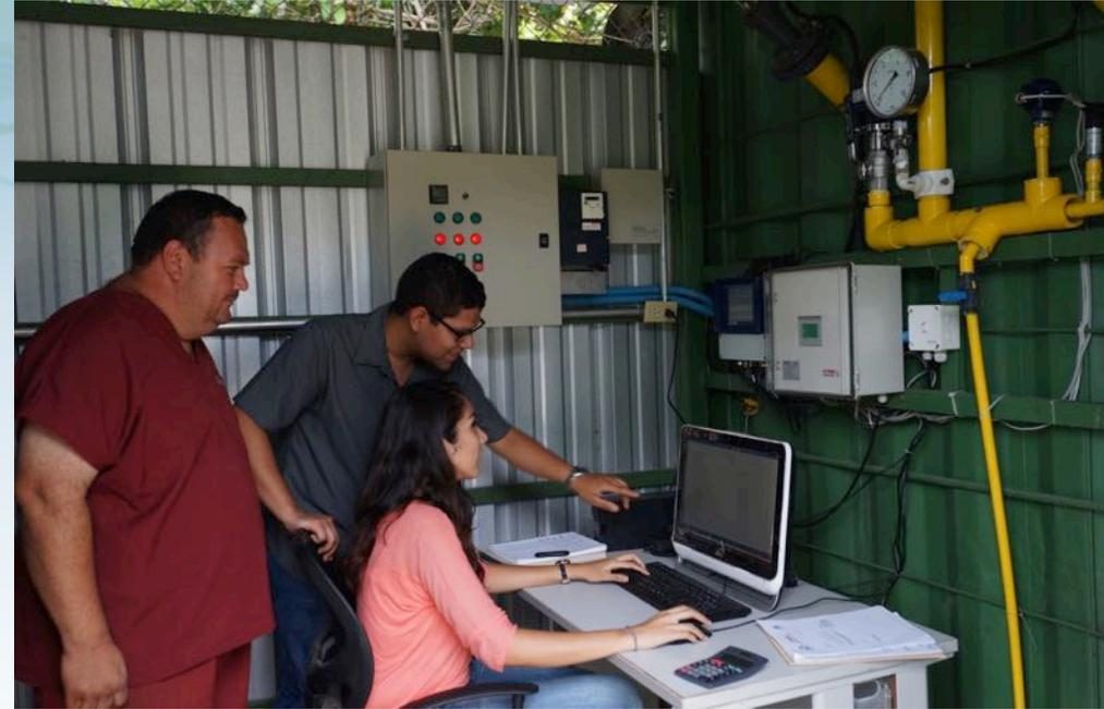
AQUALIMPIA ENGINEERING DISPONE DE TODOS LOS EQUIPOS PARA MONITOREAR PARÁMETROS OPERATIVOS EN LOS BIODIGESTORES. REALIZAMOS MEDICIONES DE CONCENTRACIÓN DE CH<sub>4</sub>, CO<sub>2</sub>, CO, O<sub>2</sub>, NH<sub>3</sub>, NH<sub>4</sub>, ETC. Y DE LA PRODUCCIÓN DE BIOGÁS.
