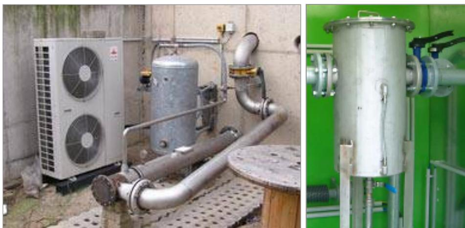
En las fotografías anteriores se muestran dos sistemas para la reducción de la humedad y eliminación de los condensados. El biogás se enfría, se forman condensados y estos se puede eliminar.
