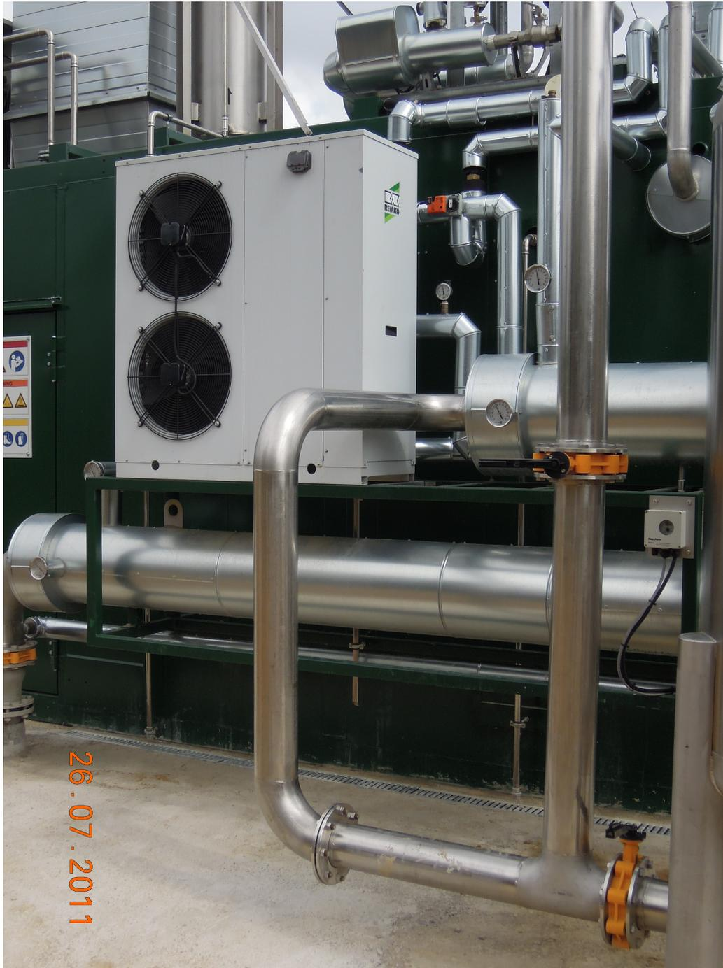
El agua de condensados y la humedad del biogás puede también reducirse o eliminarse por medio de unidades de enfriamiento de tuberías. Estas unidades se instalan antes del aprovechamiento del biogás en los generadores. Se han dado casos en que los generadores que recién se instalan en plantas de biogás se dañan a las pocas semanas de uso, debido a daños en el cigüeñal y en los pistones.
